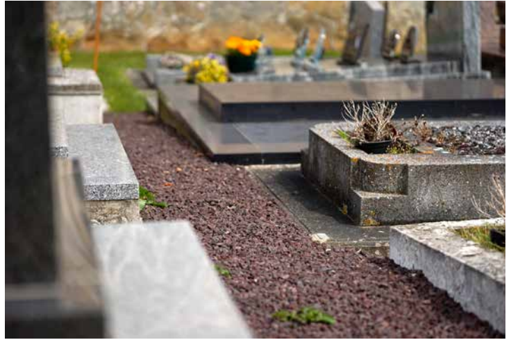
La pose d'un géotextile recouvert d'un paillage minéral (gravier, pouzzolane) est une solution pour limiter la pousse de la flore spontanée. Le temps de désherbage sera considérablement diminué pour les agents.
