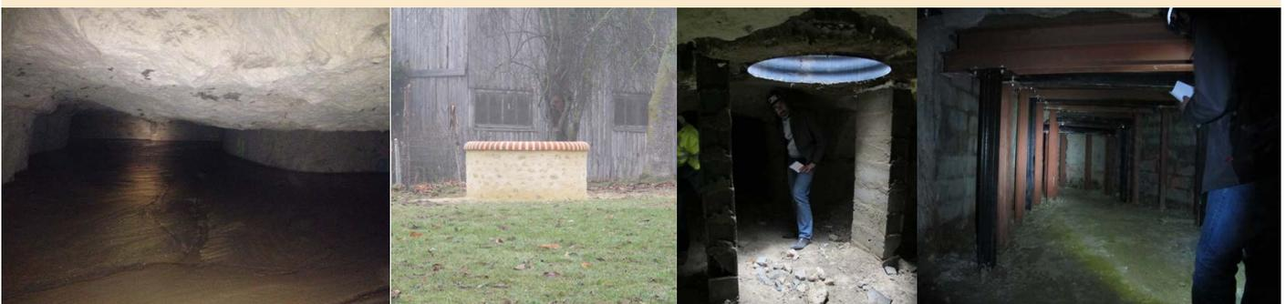
Comblement par injection - Puits d'aération et couloir sécurisé pour maintenir des conditions favorables dans la carrière pour les chauves souris (photos : M. MARTEAU).
